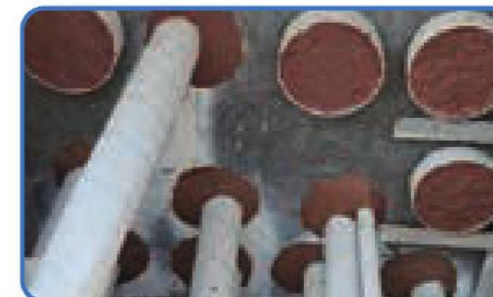
用防火堵料抹平管口
